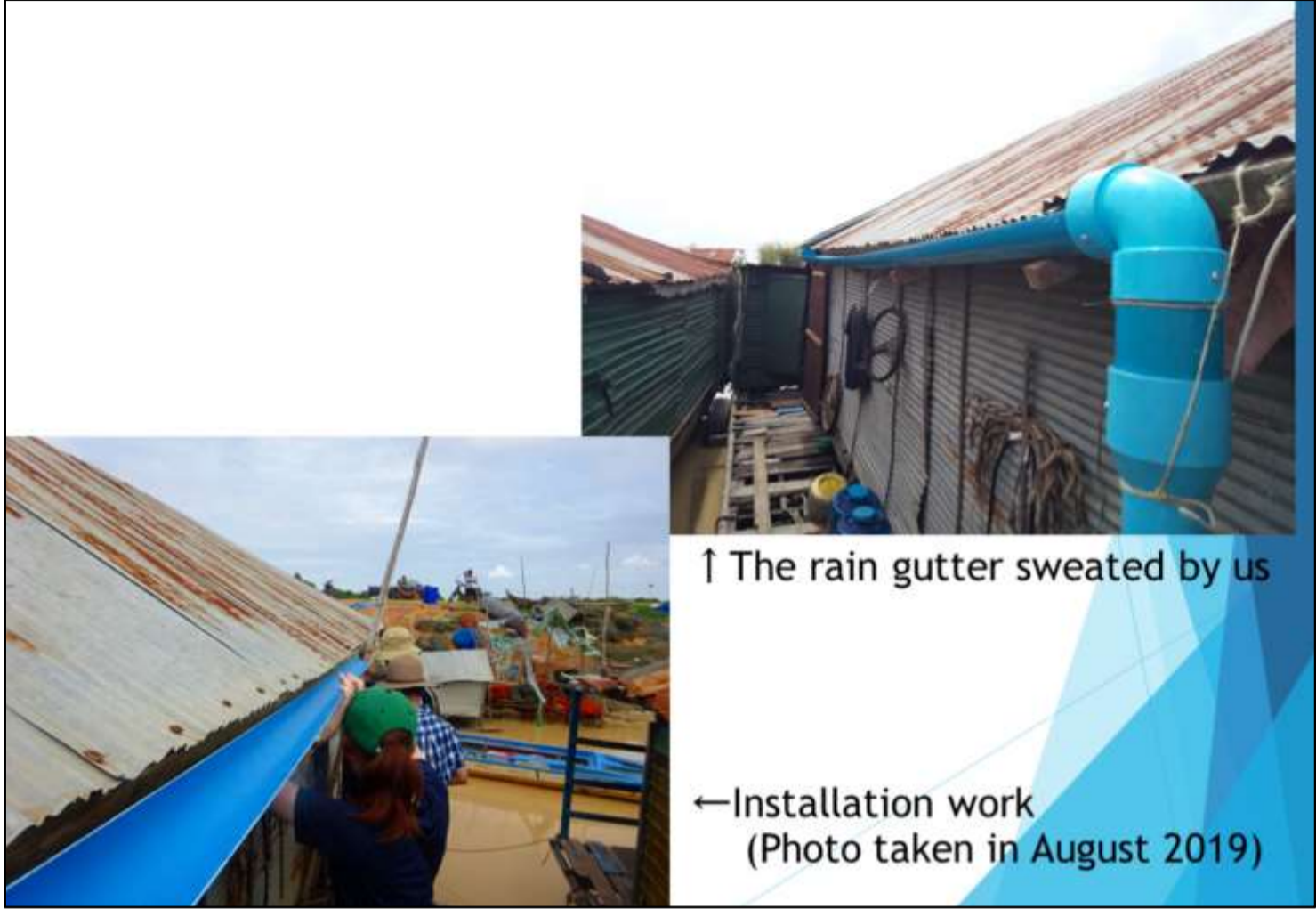
こちらは2019年8月に設置した雨樋と、その設置作業の様子の写真です。
