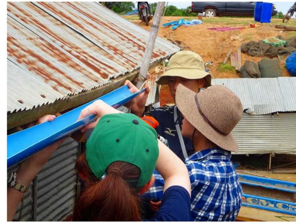
▲雨樋の取り付けの様子
